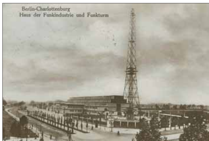
Fotokarte des noch im Bau befindlichen Funkturms. Am 26. März 1925 nach Leningrad versandt. Vor dem Turm sehen wir das aus Holz gebaute „Haus der Funkindustrie“, errichtet, um den Funkbetrieb des noch „jungen“ Rundfunks störungsfrei durchführen zu können.
